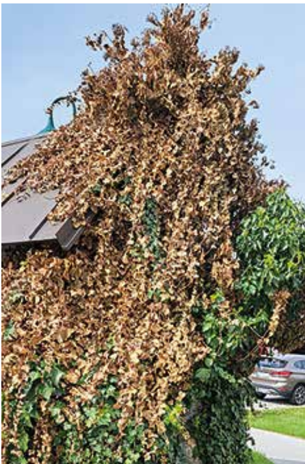
Kapelle in Mayerling, vorher
